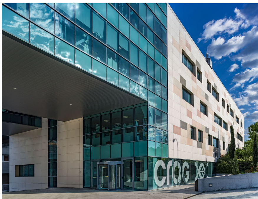
El edificio del Centro de Investigación en Agrigenómica (CRAG) en el campus de la UAB en Bellaterra (Barcelona)
